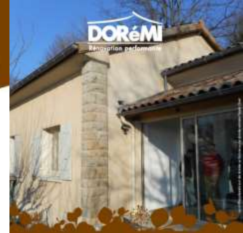
Maison construite en 1965 140 m 2 habitable Structure béton
